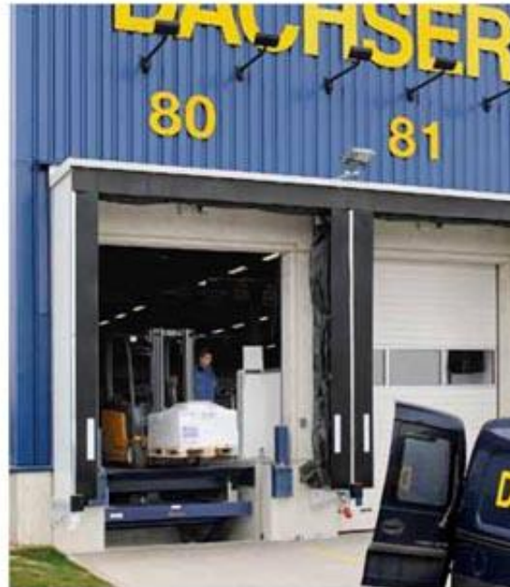
Подъёмная платформа представляет собой комбинацию перегрузочного моста с выдвижной аппарелью и платформы ножничного типа.
